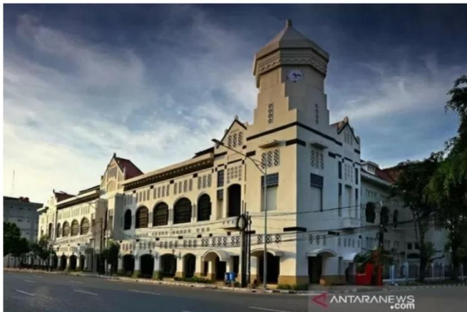
Gedung PT Asuransi Jiwasraya (Persero). ANTARA/HO-Jiwasraya/am.
